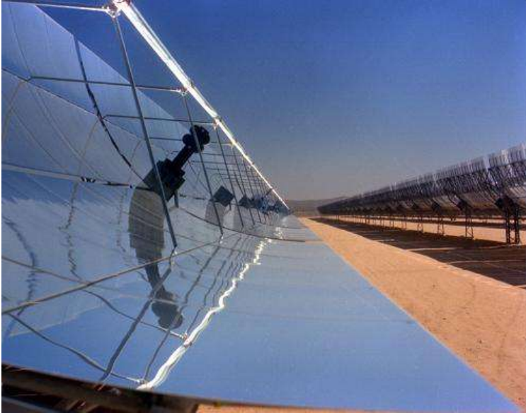
Рис. 3.28. Параболічні концентратори
