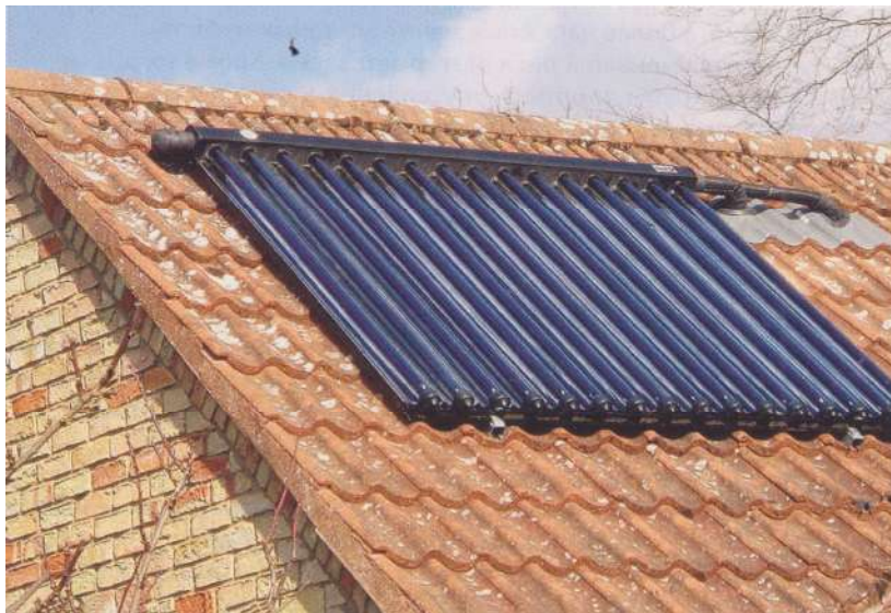
Рис. 3.21. Встановлення трубчатого колектора
