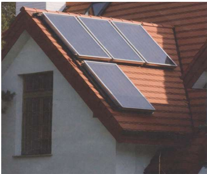
Рис. 3.22. Колектори, що працюють цілорічно
