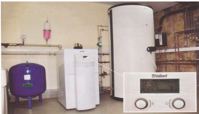
Рис. 4. 22. Обв'язка обладнання теплового насоса
