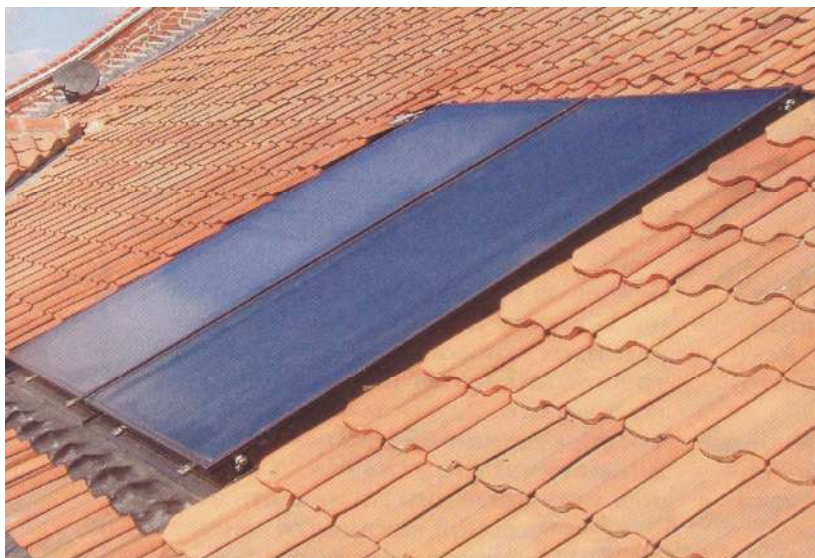
Рис. 3.20. Встановлення плоского колектора
